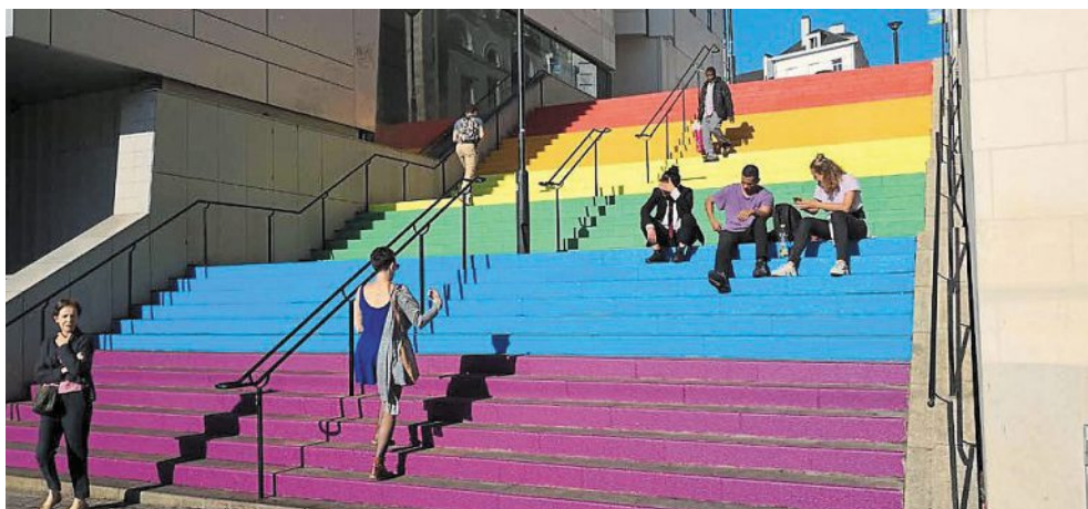
Les marches de la rue Beaurepaire avaient été dégradées dans la nuit du 13 au 14 juin. Archives PO-SP
